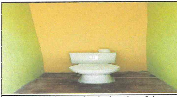
Foto 5: Pintura de interiores y exteriores de aulas, cocina, sanitarios y sus al rededores.
