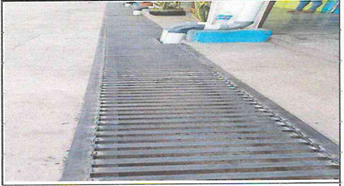
Foto 2: Cuneta de concreto y rejilla de metal
