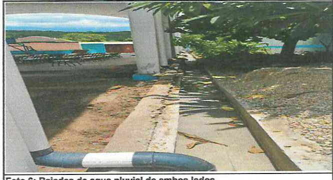
Foto 6: Bajadas de agua pluvial de ambos lados.
