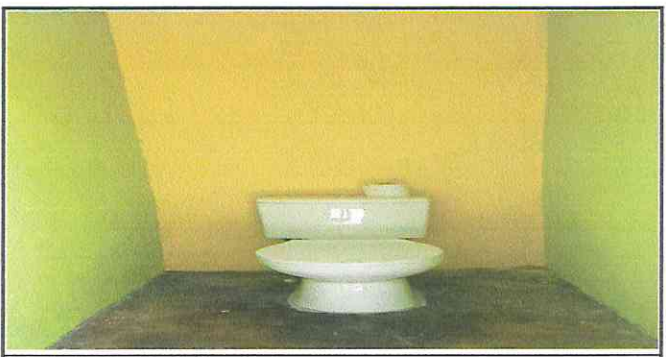
Foto 6: Instiación de 6 sanitarios
