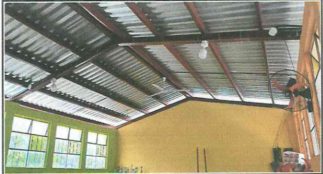
Foto 2: Estructura de soporte de metal de 4x2
