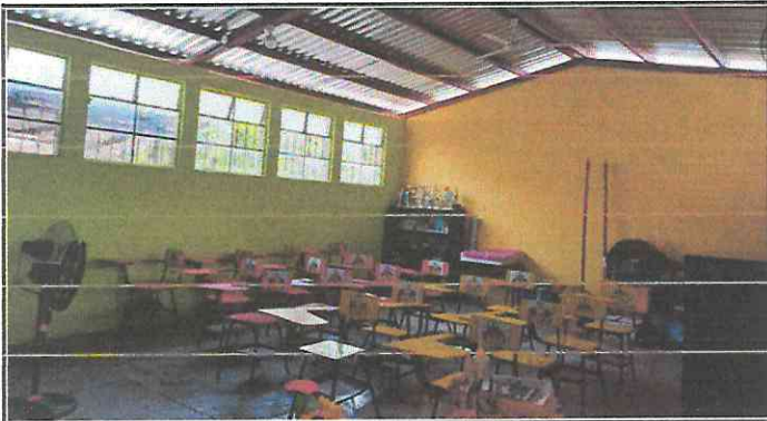
Foto1: Pintura de interiores y exteriores de aulas, cocina, sanitarios y sus al rededores.
