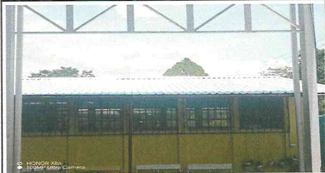
Foto1: Cubiertas de Lamina, troquelada Aluzinc calibre 26
