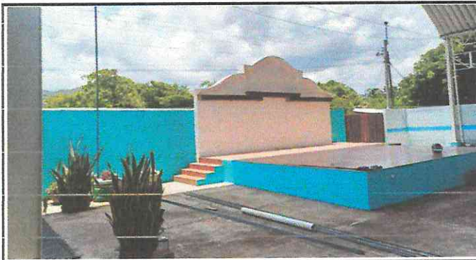
Foto 3: Pintura de interiores y exteriores de aulas, cocina, sanitarios y sus al rededores.
