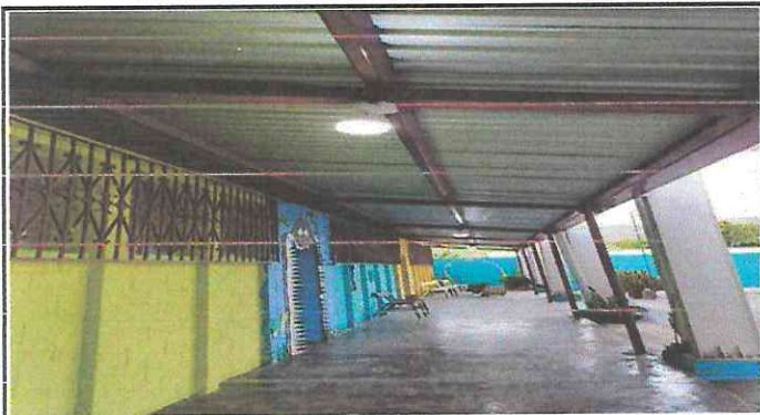
Foto 3: Sustitución de lamparas tipo led corredor, aulas, cocina y sanitarios.
