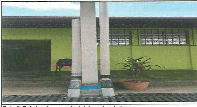
Foto 5: Bajadas de agua pluvial de ambos lados.
