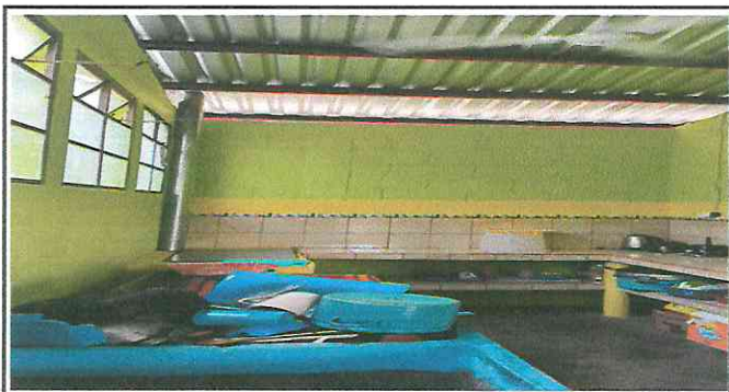
Foto 3: Reparación de estufa rural y cocina
