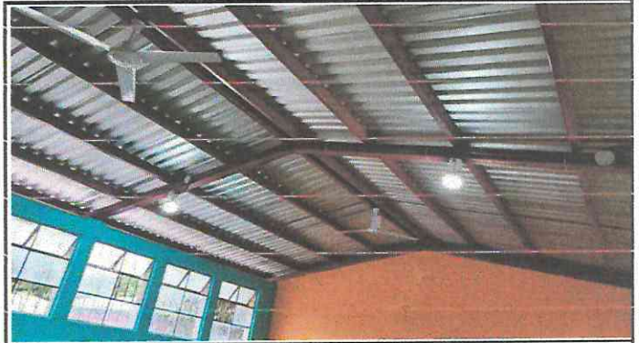
Foto 4: Sustitución de lamparas tipo led corredor, aulas, cocina y sanitarios.
