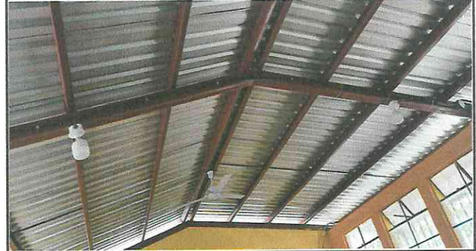
Foto 2: Cubiertas de Lamina, troquelada Aluzinc calibre 26
