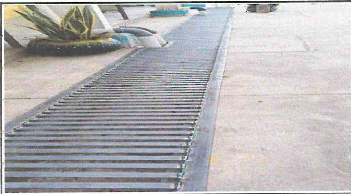
Foto1: Cuneta de concreto y rejilla de metal
