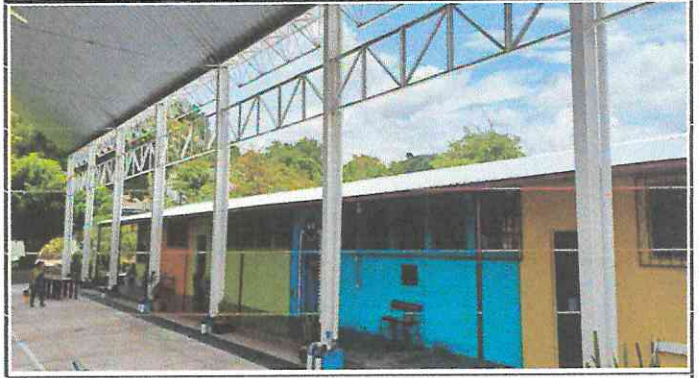
Foto 2: Pintura de interiores y exteriores de aulas, cocina, sanitarios y sus al rededores.
