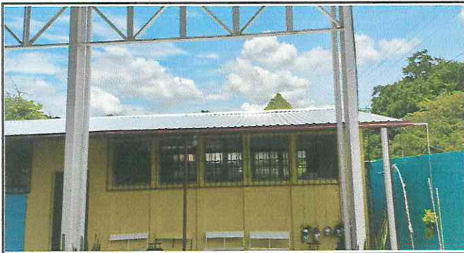
Foto 3: Canal de metal
