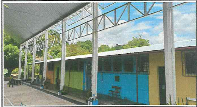
Foto 4: Canal de metal
